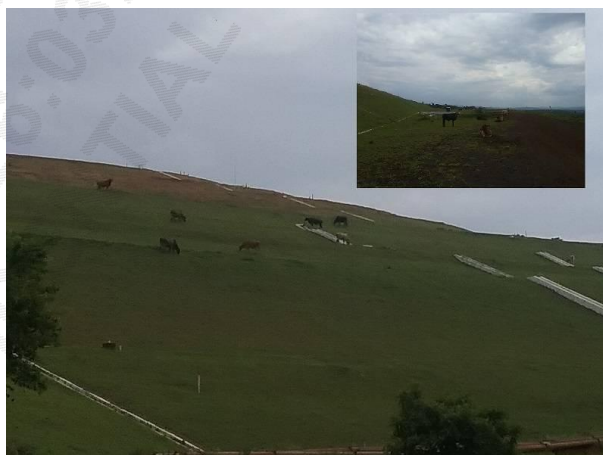
TRAFEGO DE ANIMAIS BOVINOS NA ESTRUTURA DA BARRAGEM.
