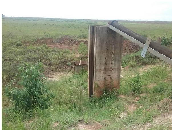
TULIPA PARCIALMETE OBSTRUÍDA POR VEGETAÇÃO.
