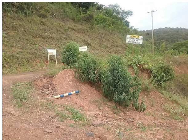
INICIO DE ROSÃO NA OMBREIRA DIREITA DE ACESSO AO EXTRAVASOR. (TULIPA)
